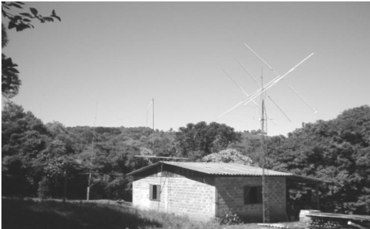
OBSERVAÇÃO: A antena foi montada e ajustada a uma altura de 2 metros do chão, neste ponto a R.O.E. estava na casa de 1:1 e quando foi instalada a uma altura de 5,50 metros do solo não houve alteração da R.O.E., mostrando-se ser uma antena de funcionamento estável. Em caso que houver uma alteração da R.O.E. basta ajustá-la através do parafuso do capacitor variável fazendo para isso um pequeno furo na proteção de PVC e logo após o ajuste faça a vedação com cola borracha de silicone.
