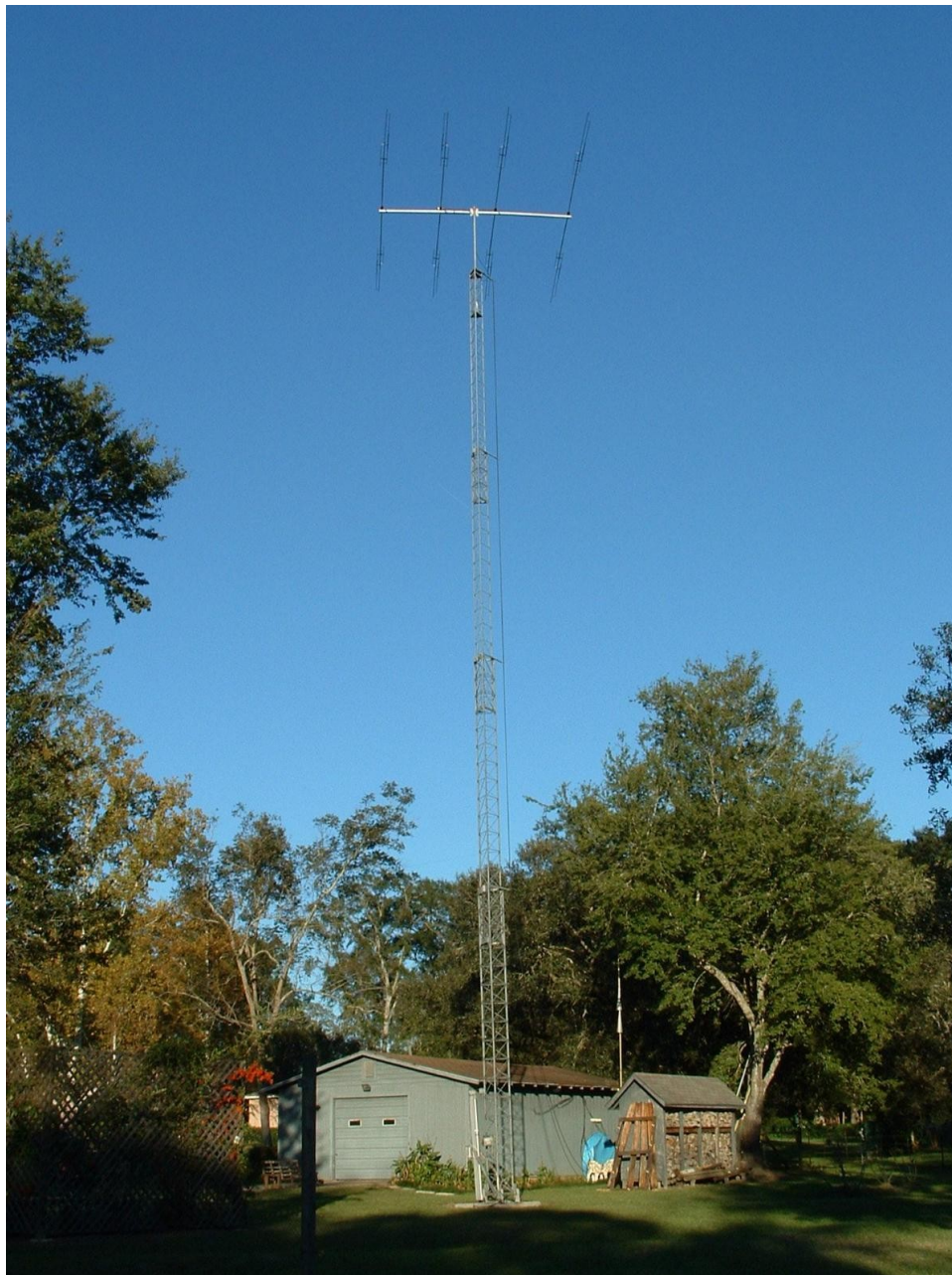
Torre construída por Eugene Oleson N7-EO. No alto, antena multibanda
